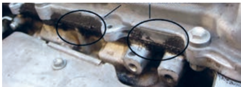
شکل ۲۷. نشتی روغن از درپوش سوپاپ‌ها
